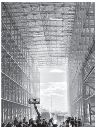
Das rund 140 Meter lange Hochregallager bietet künftig Platz für 450 Gitterboxen.
